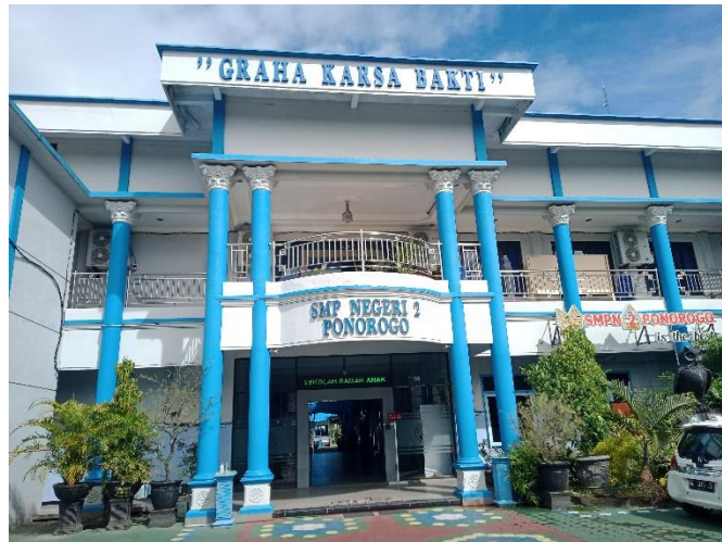
Dokumentasi Gedung SMPN 2 Ponorogo
